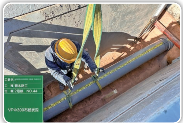
新管敷設状況(諸桑工区)
