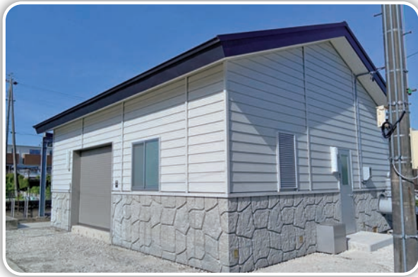
諸桑揚水機場
