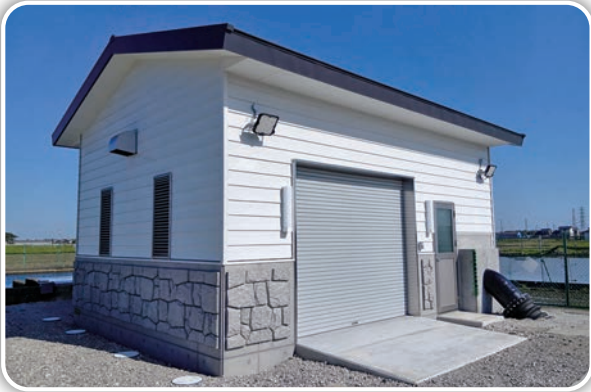
立田第2揚水機場
