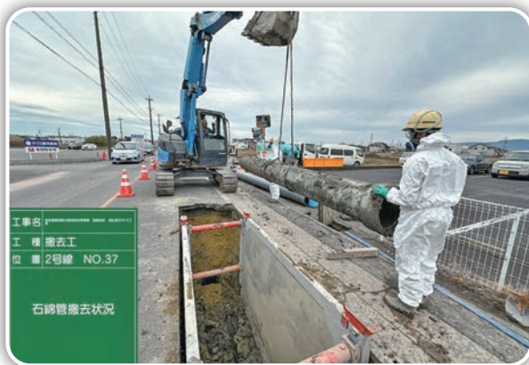
旧管撤去状況(諸桑工区)
