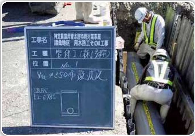
新設管布設状況
