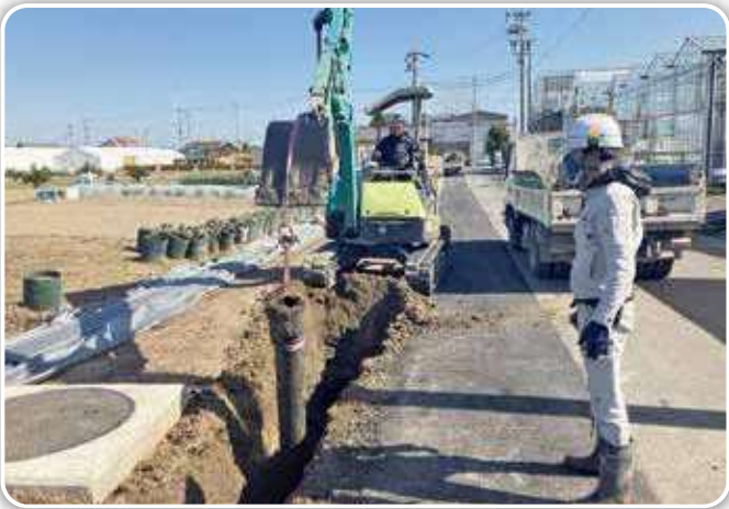
石綿管撤去状況
