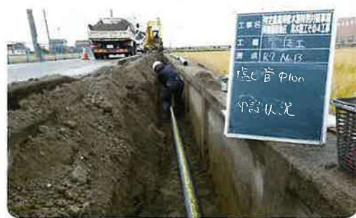
石綿管撤去状況(写真左)と 新設管布設状況(写真右)
