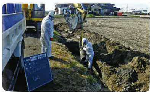
石綿管撤去状況(写真左)と 新設管布設状況(写真右)
