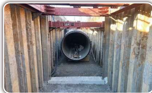
新管布設状況
