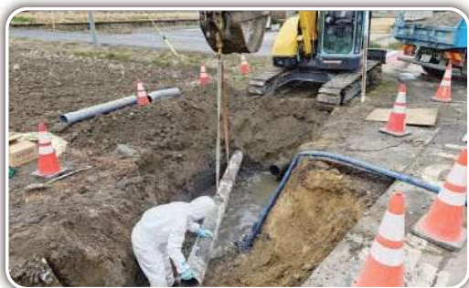
旧管撤去状況
