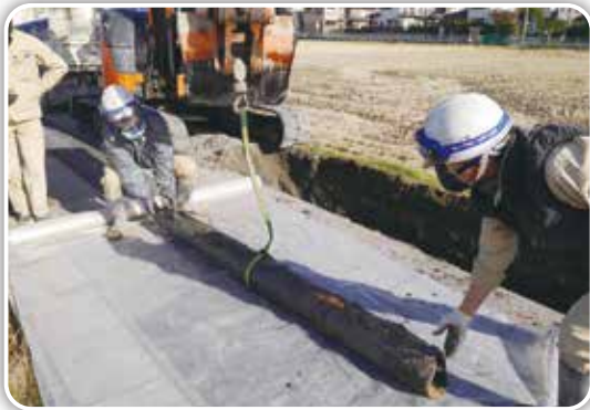
旧管撤去状況
