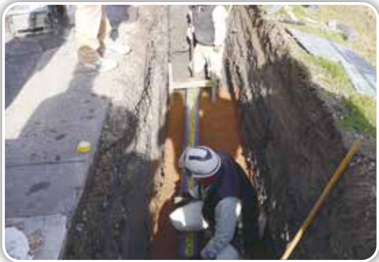
新管布設状況
