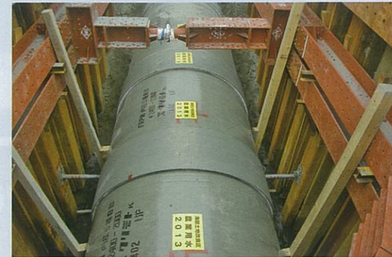
鋼平板土留め工による開削工事(FRPM管φ2,400mm)
