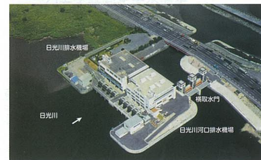
日光川河口排水機場 (隣は愛知県建設部の日光川排水機場)
