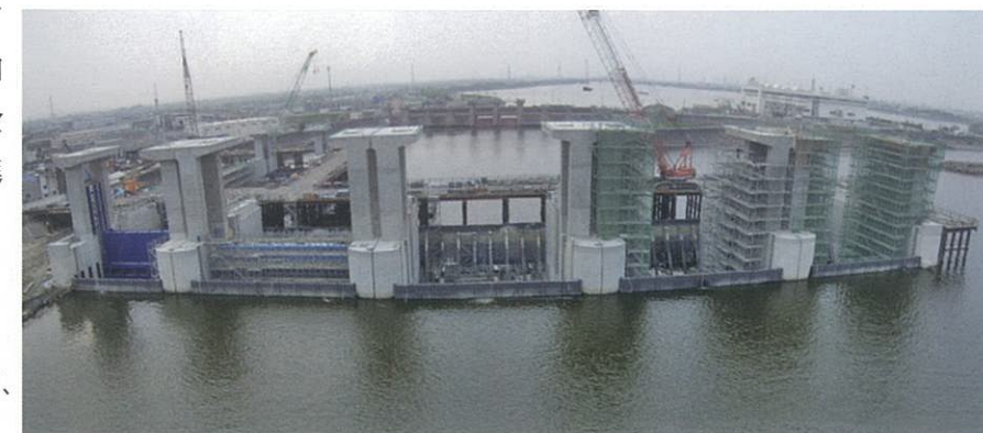
後方は、現在の水閘門、前方は、新水閘門
