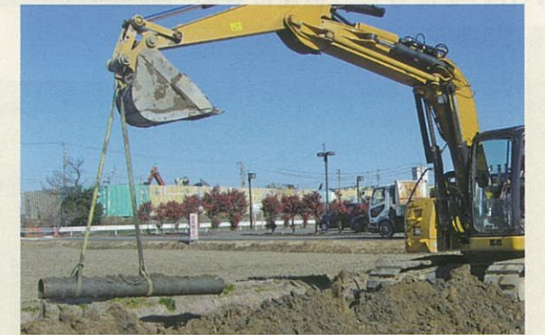
石綿管とりはずし状況
