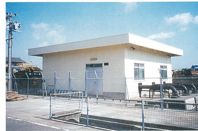
改修後揚水機場
