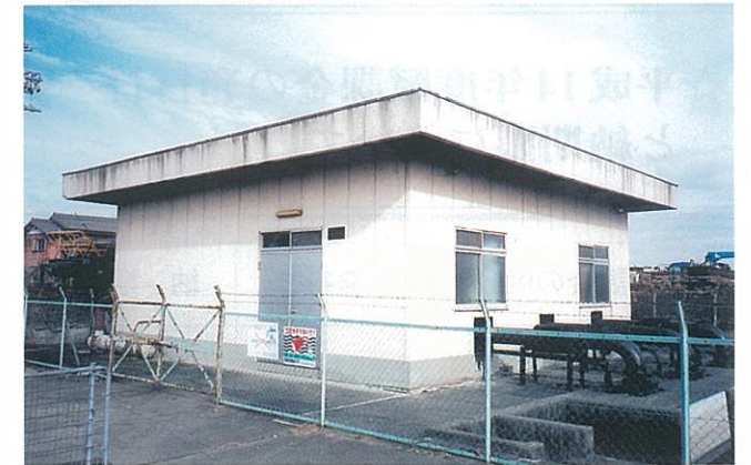
改修前揚水機場
